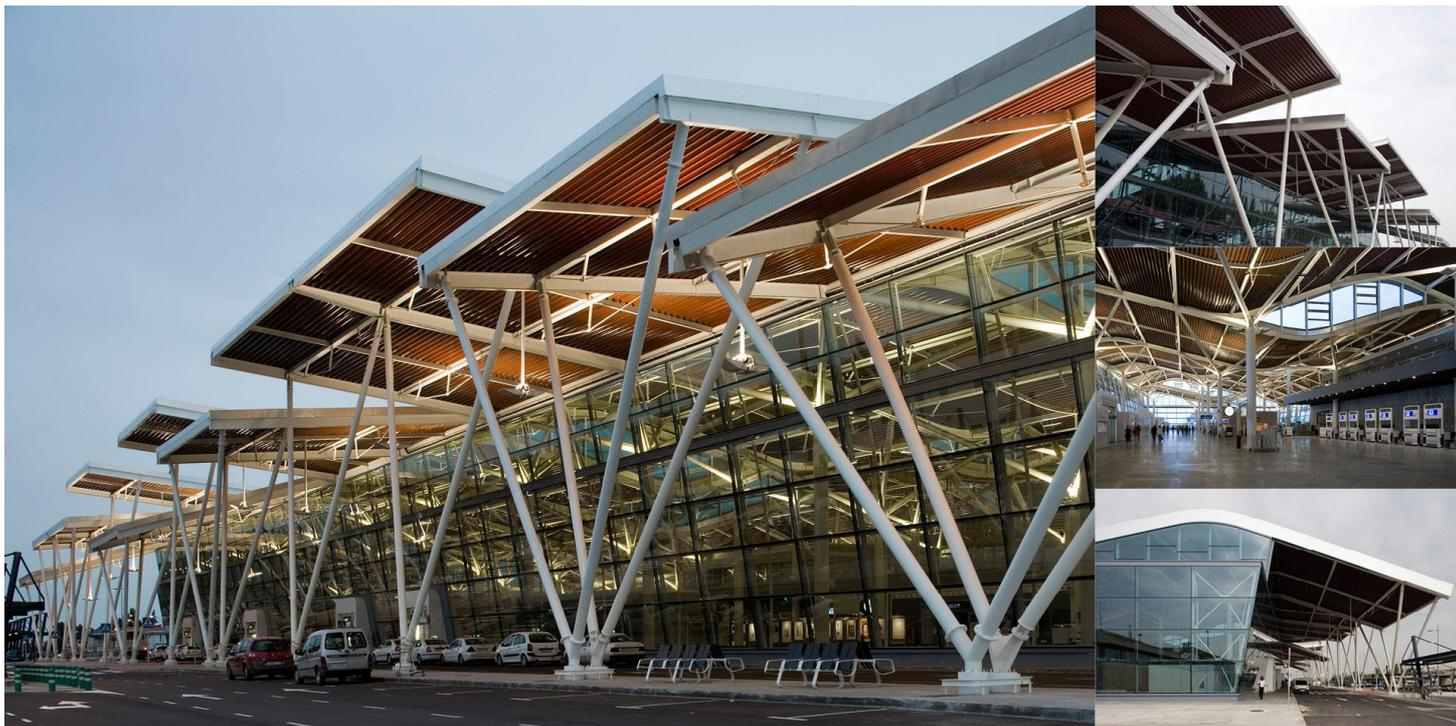
El edificio tiene en planta unos 180 m x 60 m. Cuenta con sótano y planta baja completos, más una planta primera de 45 x 20 metros.
